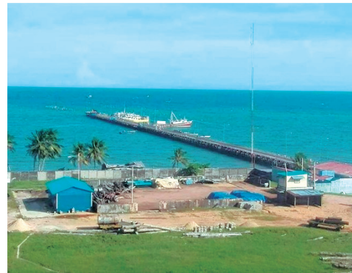
Muelle de Puerto Cabezas (construido en el año 1924). Fotografía INC.
