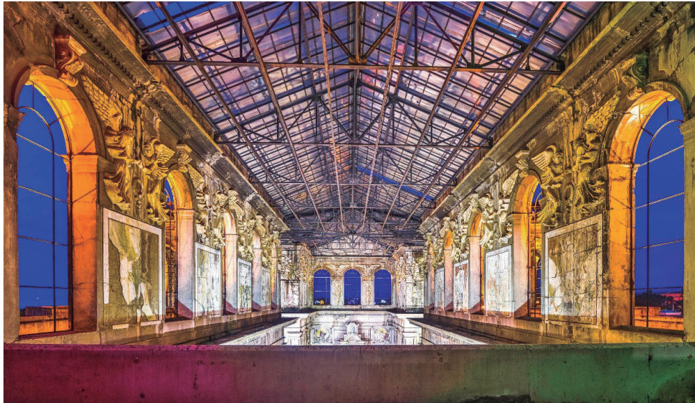
Interior antigua Catedral de Managua. Fuente: Universidad Nacional de Ingeniería – Diex. Solís, Álvaro (Fotografía).
