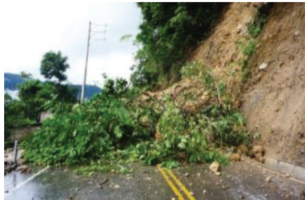
Lámina 11: Derrumbe en la cuesta La Kukamonga, Estelí, 2013. Tomada de: http://cdn.nuevaya.com.ni/wp-content/uploads/2013/06/HUAIICOS-Y-DERRUMBES-AFECTAN-CARRETERAS-1.jpg
