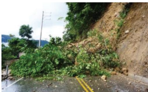
Lámina 16: Derrumbe en la cuesta La Kukamonga, Estelí, 2013. Tomada de: http://cdn.nuevaya.com.ni/wp-content/uploads/2013/06/HUAICOS-Y-DERRUMBES-AFECTAN-CARRETERAS-1.jpg
