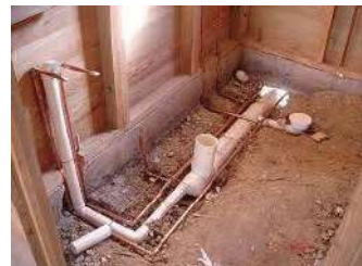
Tubería alcantarillado de PVC
