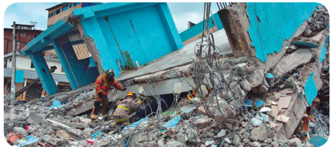
Terremoto en Ecuador (Abril 2016)
