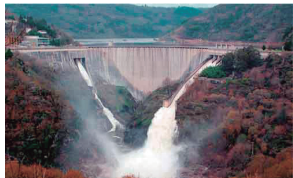
Planta Hidroeléctrica Larreynaga, instalada en la cuenca del Río Viejo, departamento de Jinotega
