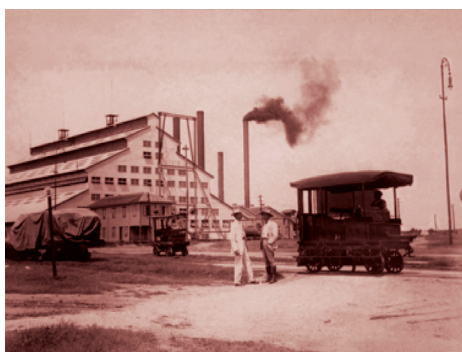
Primera planta de procesamiento de la caña de azúcar y destilería en el Ingenio San Antonio
