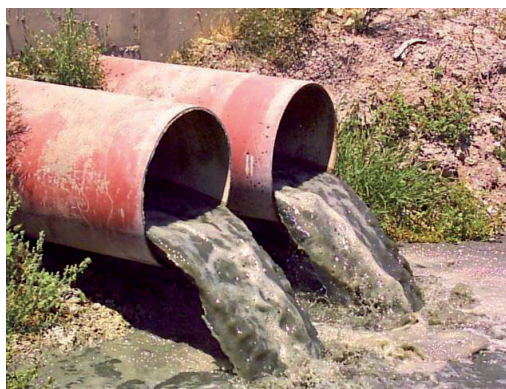
Contaminación por aguas residuales
