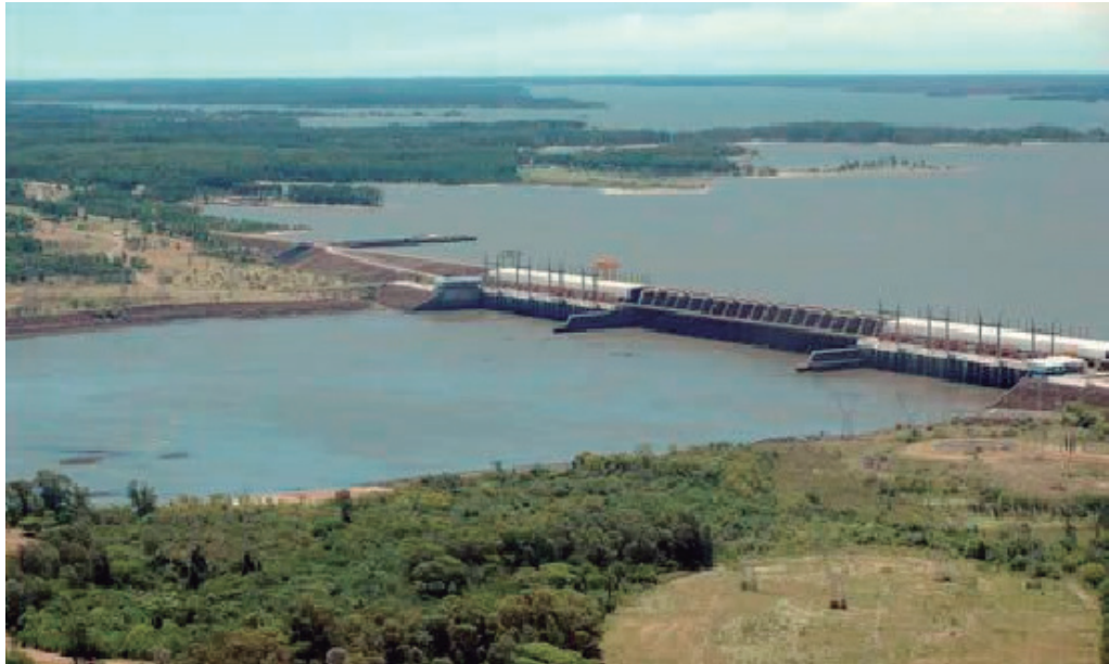
Aprovechamiento de los Recursos Naturales, Represa Hidroeléctrica.
