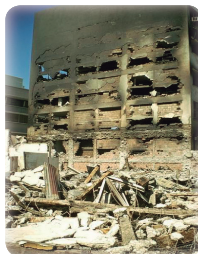
Terremoto de Managua, 1972
