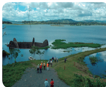
Planta hidroeléctrica de Apanás
