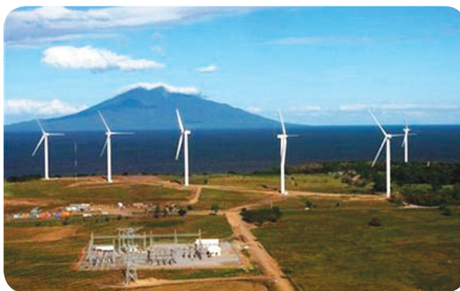
Energía - Eólica, Rivas
