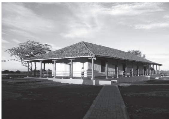
Fig. 1 Fachada arquitectónica y actual estado de conservación de la casa hacienda de San Jacinto (Foto tomada de: Ramiro García)
