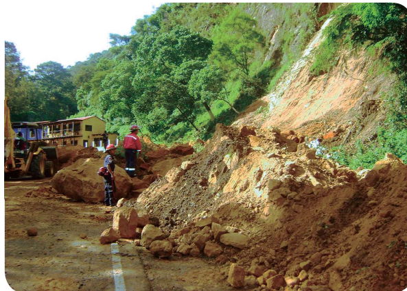
Derrumbe sobre carretera
